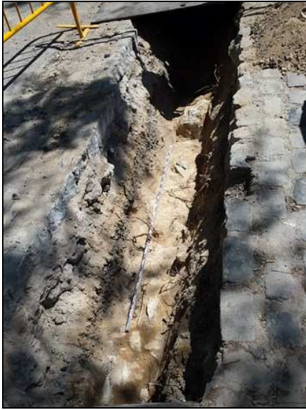
Estructura UE 604 al segon tram
