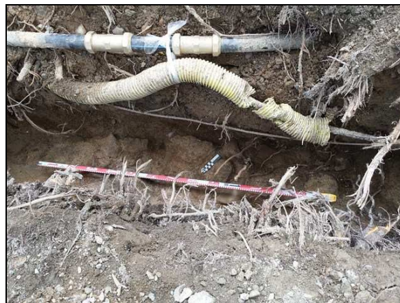
Estratigrafia i estructura UE 604 al tercer tram de la rasa
