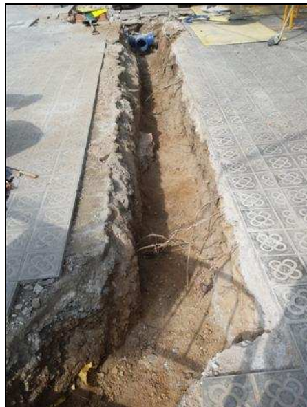
Imatge SW de part de la rasa 700 un cop finalitzada
