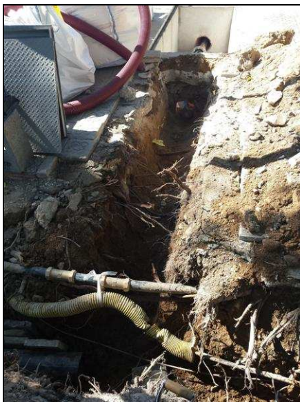
Vista SE de la rasa
