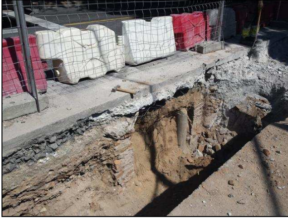
Imatge d'una arqueta amb un dels serveis localitzats a la rasa
