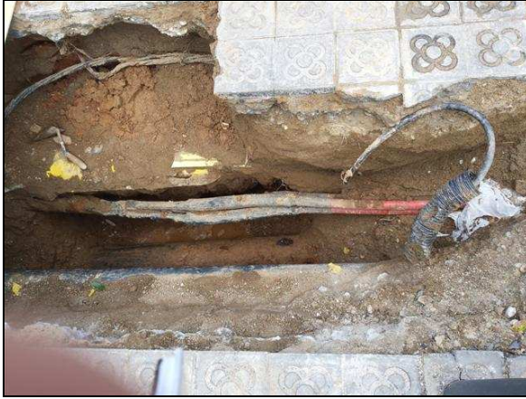
Imatge de la cala de comprovació abans de realitzar la rasa 200
