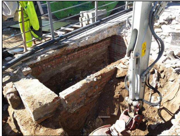
Vista de l'estructura de maons UE 206 amb l'arqueta de actual de servei d'aigua recolzada a ella i a la fonamentació UE 205
