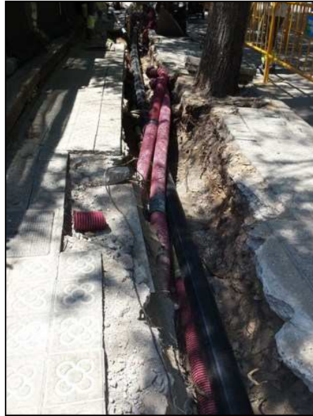
Rasa 600 amb el nou tub d'aigua
