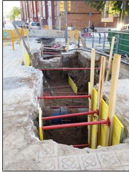
Vista NE de la rasa 200
